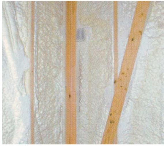
現場での発砲施工により隙間を解消し、遮音性・気密性・断熱性を強化。1年を通じて温度差が小さく、心地よい暮らしができます。
